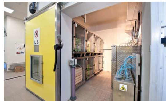
KühlleimVersuchslagerhaus des Versuchszentrum Laimburg
